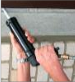
Spritzen – Fugen professionell und sauber verfüllen
