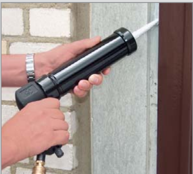
Spritzen – Fugen professionell und sauber verfüllen
